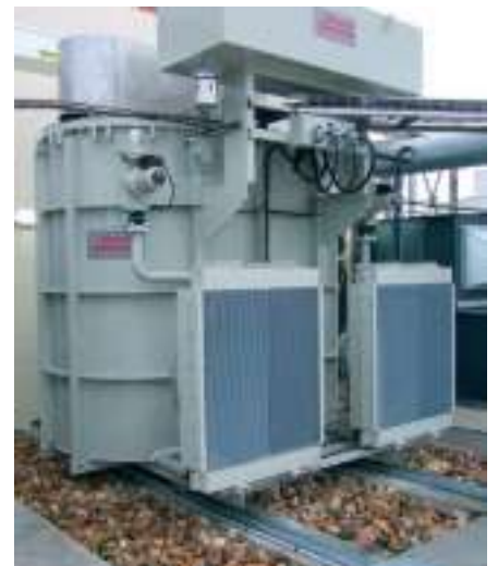
Refroidisseur d'huile stationnaire pour transformateurs, Bernard & Bonnefond
